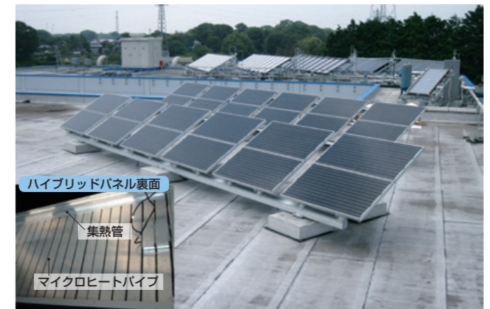
*1 熱取得モジュール マイクロヒートパイプと集熱管から構成され、太陽電池パネルの裏面の熱をヒートパイプにより吸収するとともに集熱管を通る液体と熱交換する装置。
