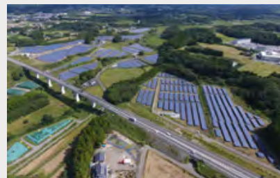
大熊エネルギー・メガソーラー発電所（福島県）
